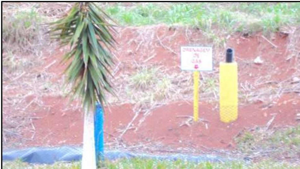
**Figura 117: Sistema de drenagem de gás.**
