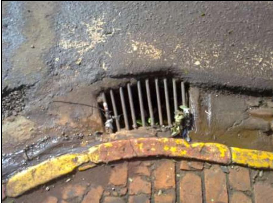
**Figura 139: Caixa Coletora com gradeamento**
