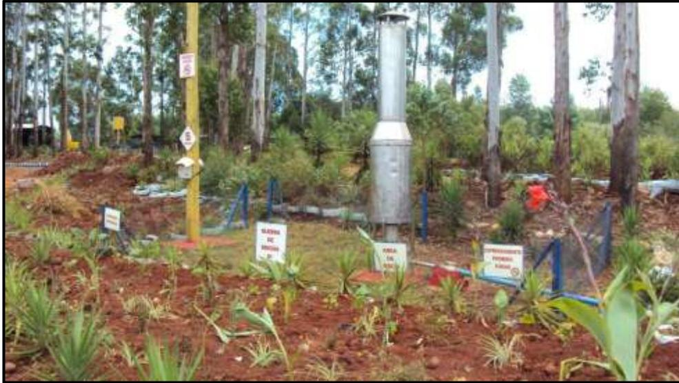
**Figura 118: Sistema de queimadores de biogás.**
