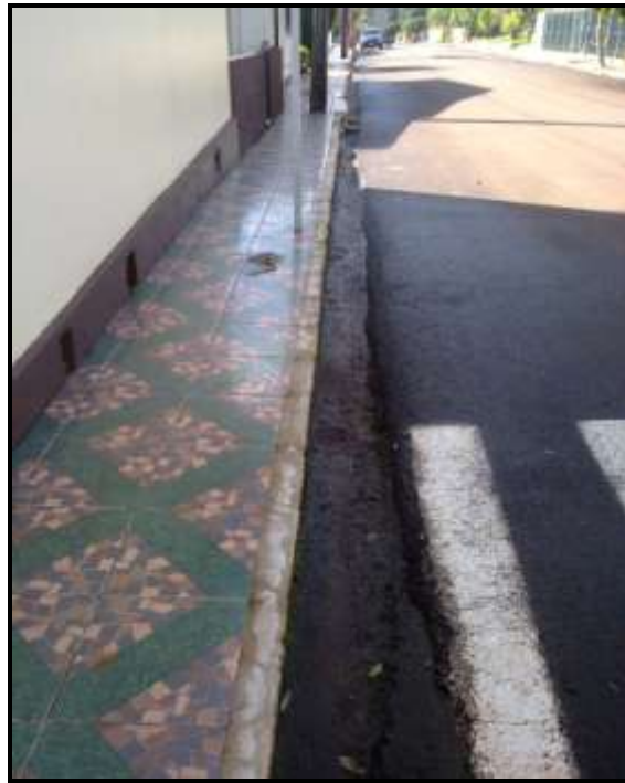
Figura 42: Sarjeta e meio fio
