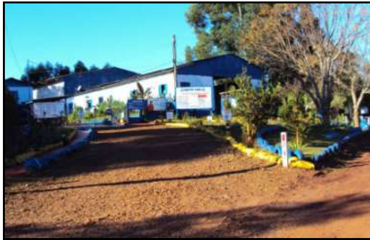
Figura 23: Controle de acesso na entrada da empresa SIMPEX
