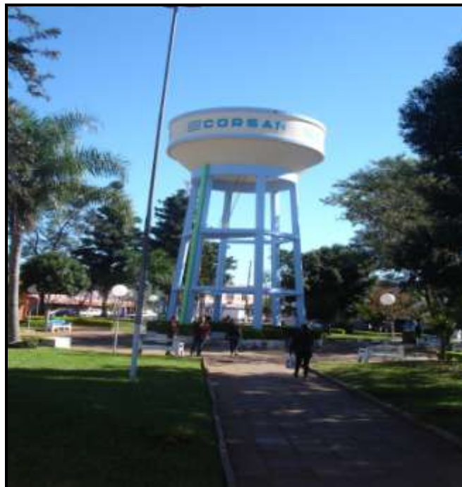
Figura 10 – Reservatório Corsan – Praça
