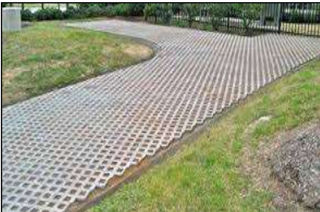
Figura 47: Revestimento com Paivers nos passeios público
