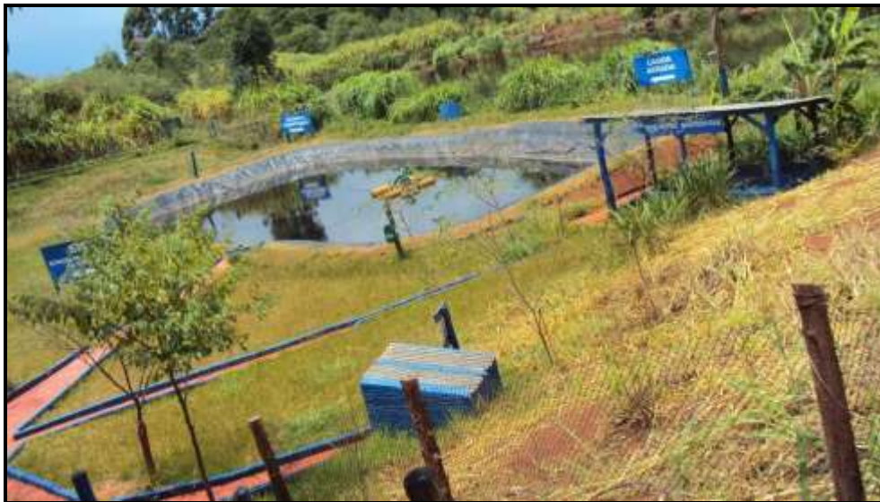
Figura 33: Lagoa aerada na ETE da empresa SIMPEX
