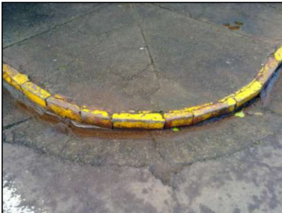
Figura 43: Sarjeta e meio fio
