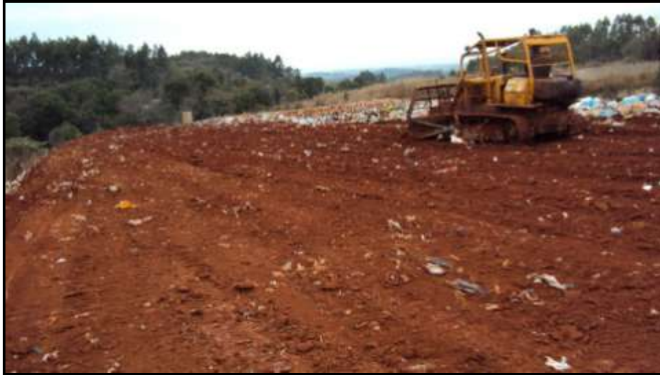
Figura 28: Compactação de Resíduos na célula .
