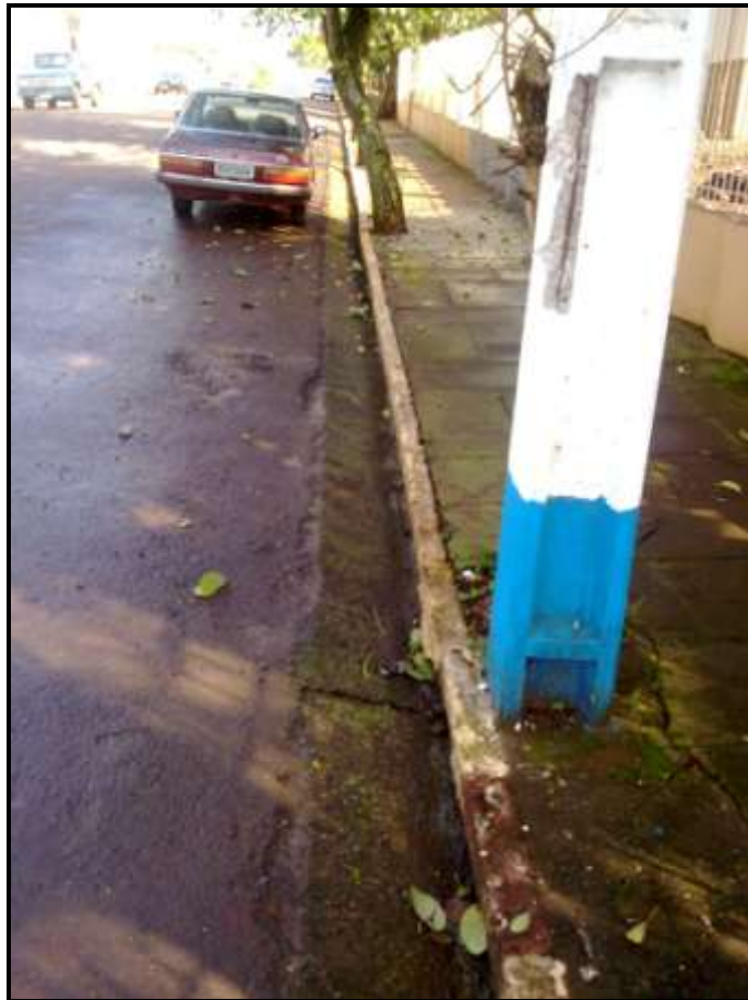
Figura 40: Facilidade no escoamento das Águas Pluviais
