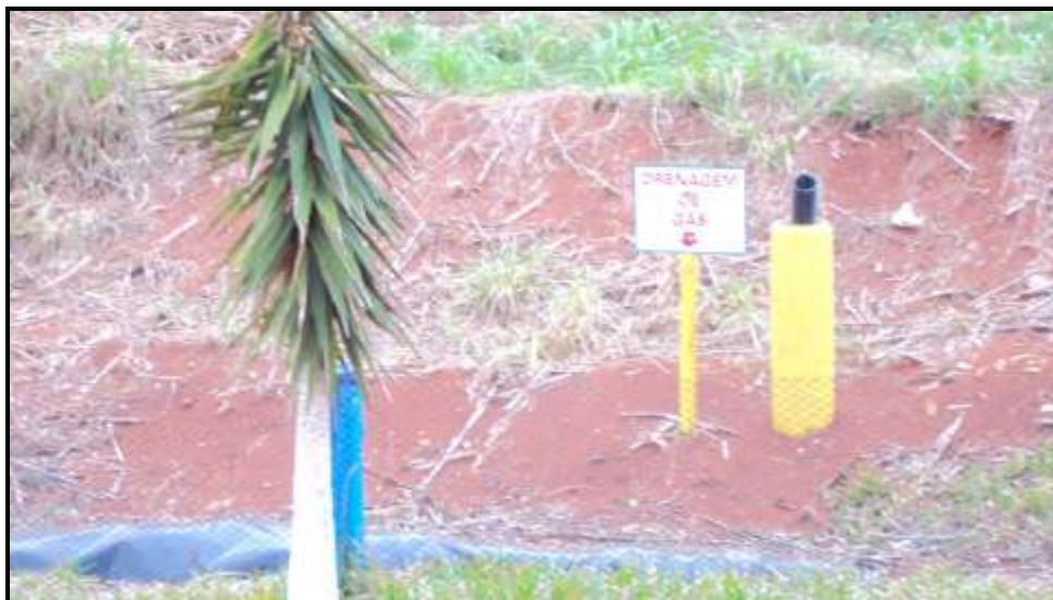
Figura 29: Sistema de drenagem de gás.
