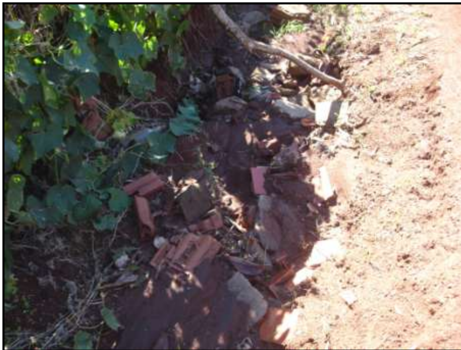
Figura 7: Entulhos utilizados para aterramentos Fonte: Cerne Ambiental
